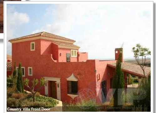
Country Villas Front Door
